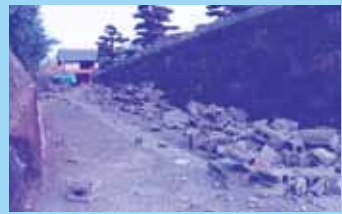
本震直後… ブロックや瓦が落ちている 家庭は目立ちました
